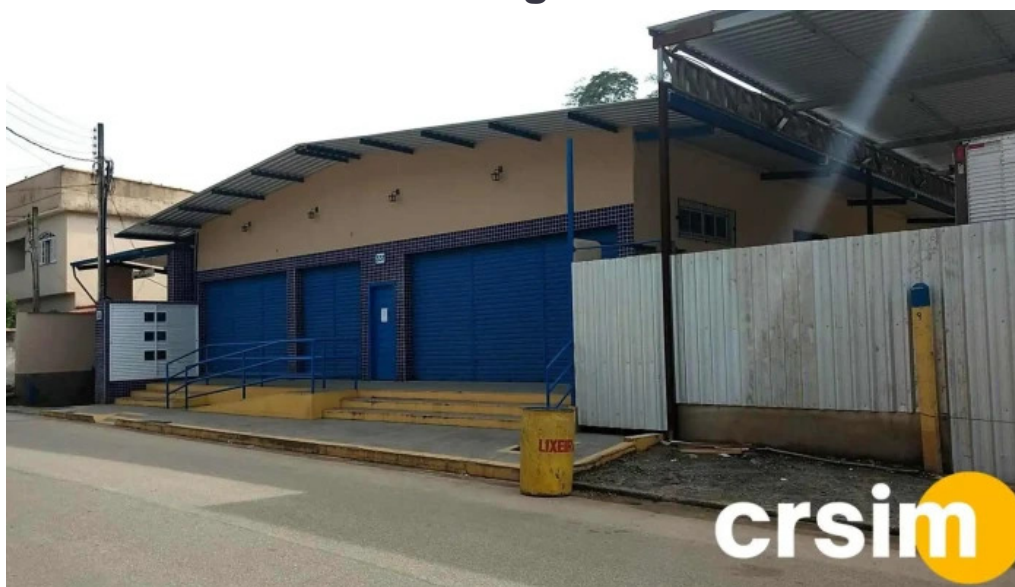
Deposito bruno eletromoveis tudo
