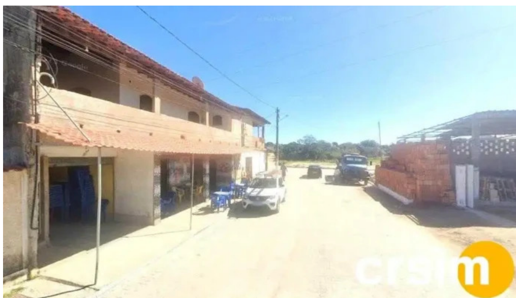
Fort laje de iguaba iguaba grande
